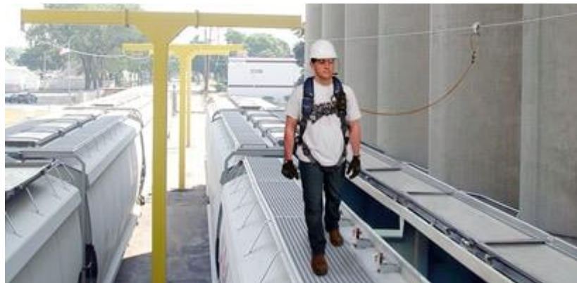
ภาพที่ 3-3 การติดตั้งสายช่วยชีวิตแนวนอนระหว่างจุดยึดเกี่ยวตลอดพื้นที่ปฏิบัติงาน และ ผู้ปฏิบัติงานต้องสวมใส่อุปกรณ์คุ้มครองความปลอดภัยจากการตกจากที่สูงตลอดระยะเวลาการปฏิบัติงาน
